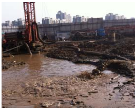
图 5.2.2-1 钻孔桩施工泥浆排放大
