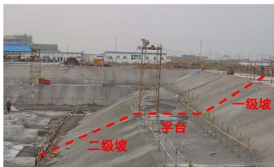
图 5.2.1-1 放坡开挖土方量大
