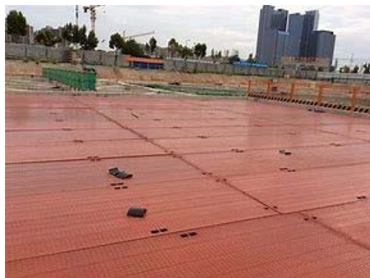
图 5.2.6-2 装配式钢栈桥面板
