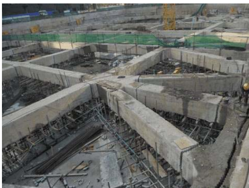
图 5.2.4-1 混凝土支撑拆除
