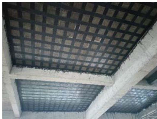
图 8.2.5-2 碳纤维复合材料加固
